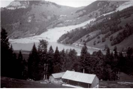
1. Glissement de terrain et le lac (1943) depuis le Sud du Lac.
