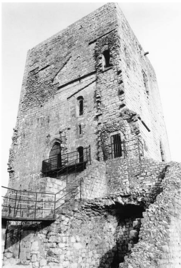
Fig. 13 : Donjon, façade ouest.
