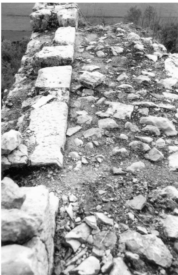
Fig. 41 : Courtine sud-est, vestiges des dispositifs sommitaux.
