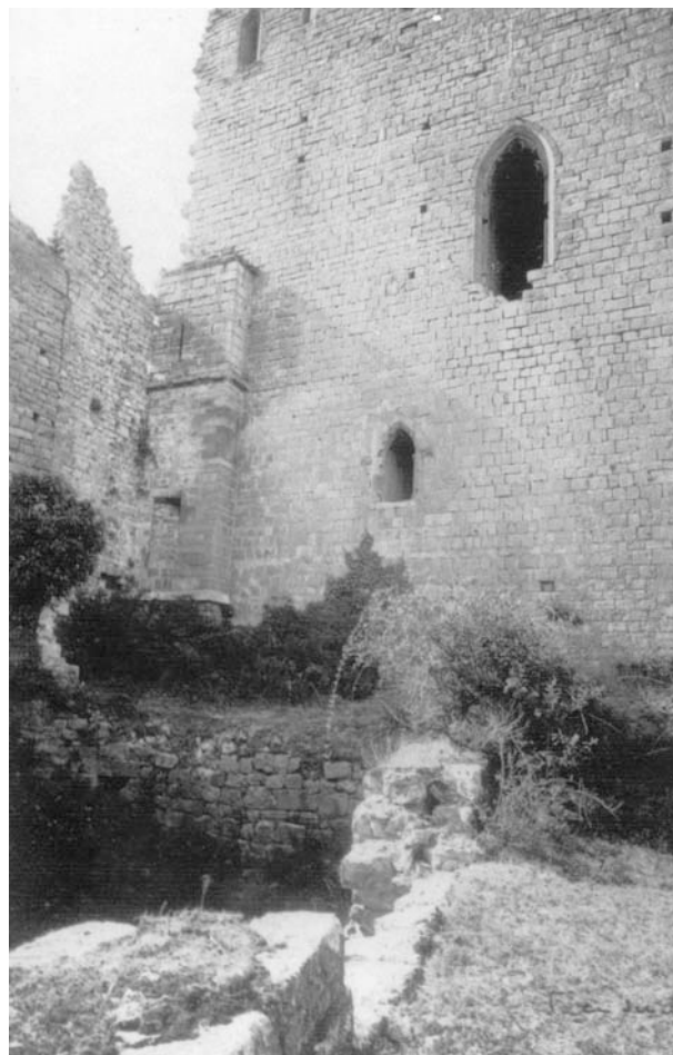
Fig. 45 : Vestiges au pied de la face sud de la tour maîtresse en 1906.
