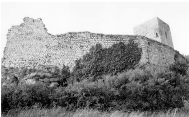
Fig. 32 : Pointe occidentale de l'éperon, partie d'enceinte conservée en élévation.
