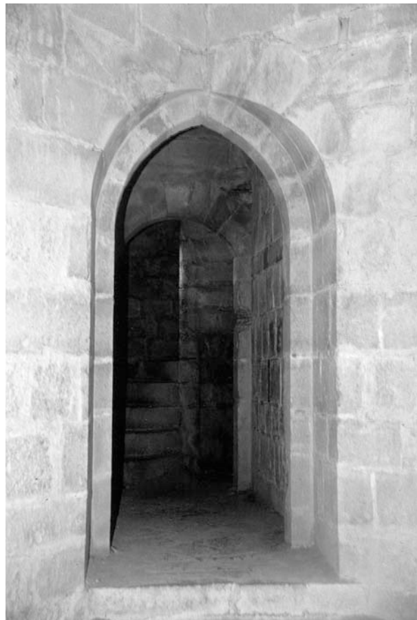
Fig. 14 : Salle des Gardes , porte d'accès.
